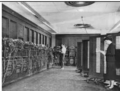
De eerste computer, de Eniac, zo groot dat een zaal gevuld was met rekeneenheden (=computers)!
